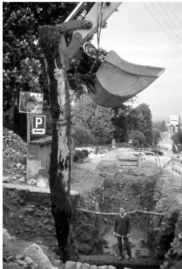
Prélèvement d'une des solives du pont de la porte de Payerne au printemps 2006
