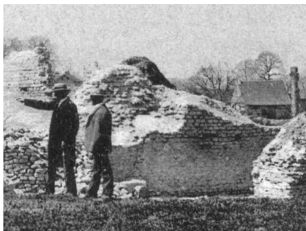
Photo prise en 1893 lors des premiers travaux de réfection au théâtre antique. Le personnage de droite pourrait être Auguste Rosset en compagnie de l'architecte Th. van Muyden
