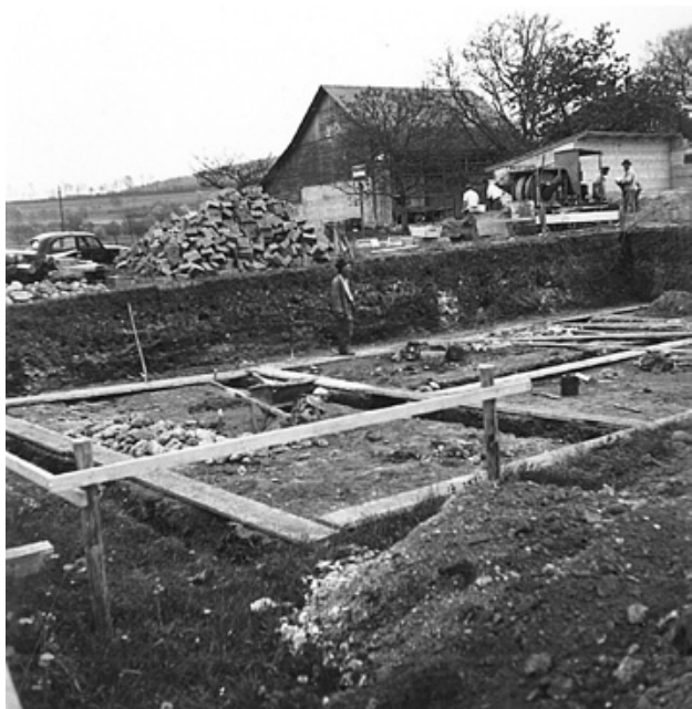
Fig. 29 (à g.) 1946.02. Insula 15. Avril 1946, fouille d'urgence engagée in extremis par Louis Bosset suite à l'apparition de vestiges au fond de l'excavation réalisée pour la construction du quatrième bâtiment locatif de la société industrielle Aventica SA.
