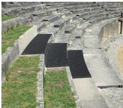
Fig. 25 – Amphithéâtre. Nouvelle installation de gradins en acier peint couvrant le carcer nord.
