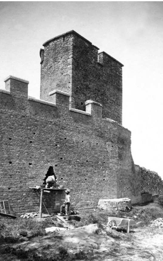
Fig. 13 – Travaux de restauration sur le mur d'enceinte, au pied de la Tornallaz (1921)
