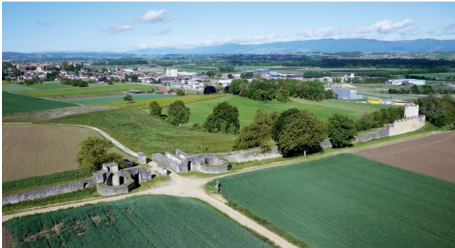
Fig. 27 – Vue de la porte de l'Est, du rempart et de la tour de la Tornallaz (à dr.). À l'arrière-plan, la ville d'Avenches. Photo aérienne prise au moyen d'un drone
