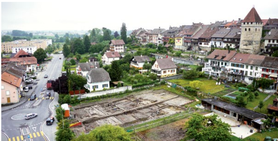
Fig. 30 – Situation du chantier de la route du Faubourg, au sud de la colline d'Avenches Photo NVP3D, La Croix-sur-Lutry
