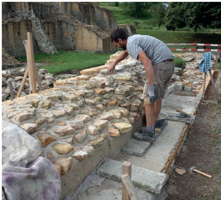
**52** Théâtre romain. Détails de la maçonnerie d'origine du mur M10 après dérestauration. On y voit le noyau maçonné en calcaire jaune du Jura ainsi que le lit d'attente pour la pose de blocs en grand appareil de grès coquillier de la « ceinture ».
