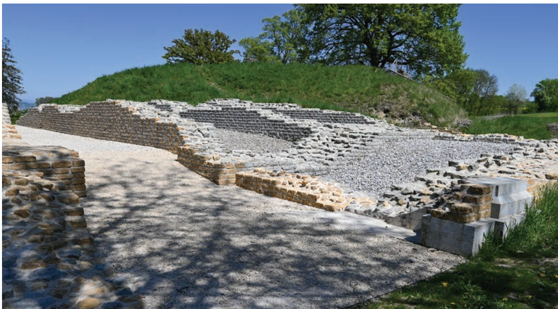
51 Théâtre. Entrée de vomitoire 10 après restauration finale.
