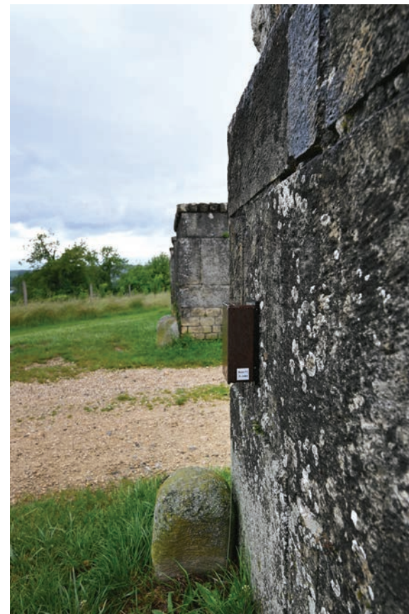
61 Valorisation. Dispositif de comptage d'affluence installé à la porte de l'Est.
