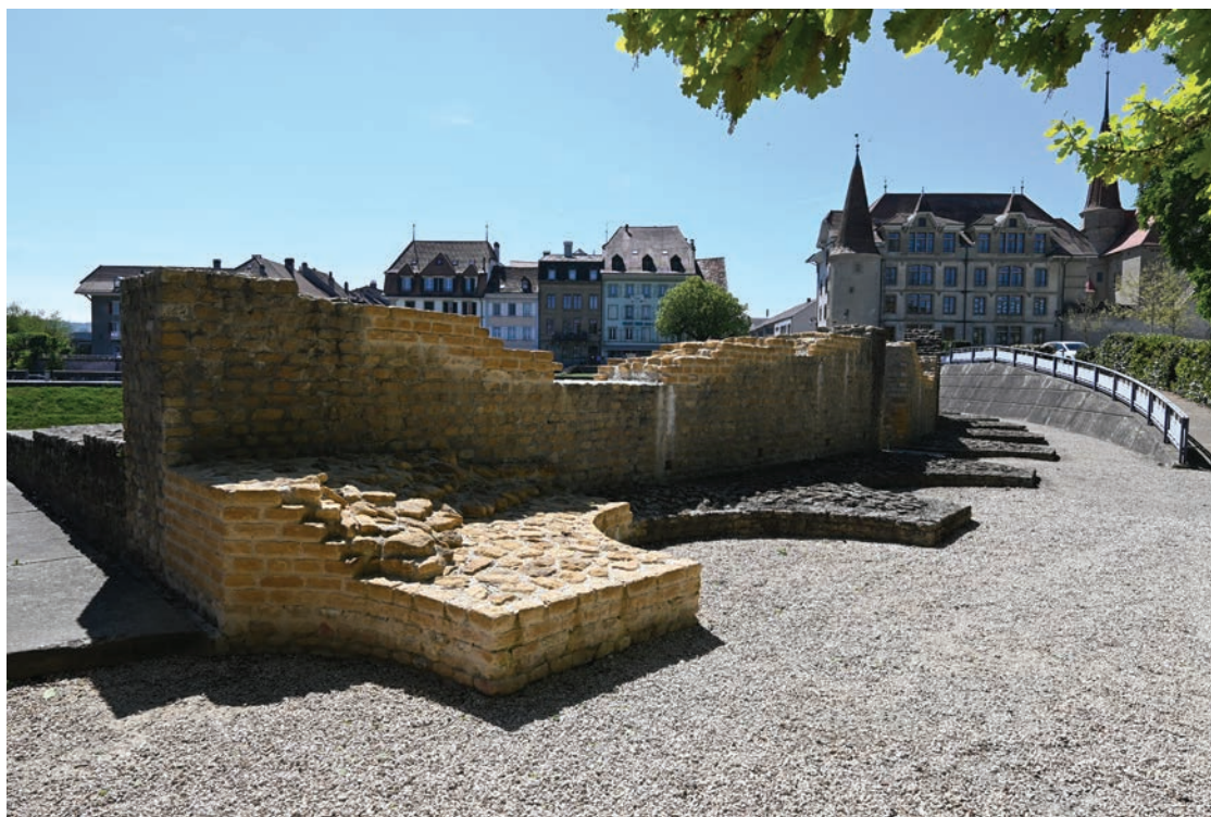
58 Amphithéâtre. Résultats des tests de finition sur l'arase des murs et des alcôves nord-est.
