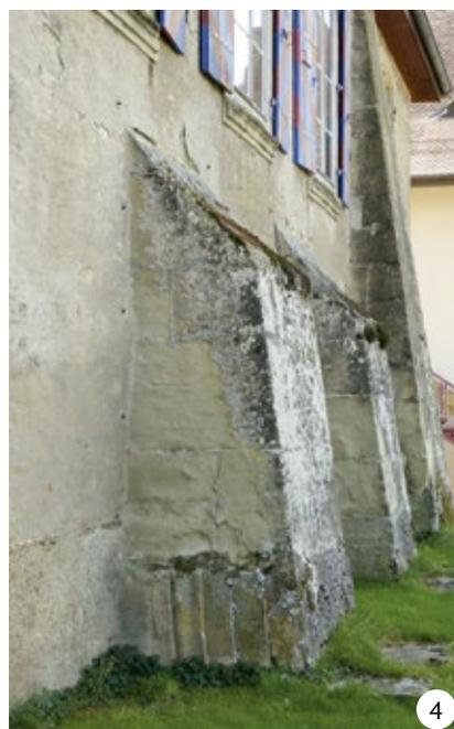
**Du sanctuaire du Cigognier au château d'Avenches : deux rangées de blocs en remploi dans la partie inférieure du corps de logis (en haut) ; divers éléments recyclés à la bases des contreforts de la partie d'habitation, parmi lesquels on peut reconnaître les fragments d'un arc profilé (ci-dessus)**
