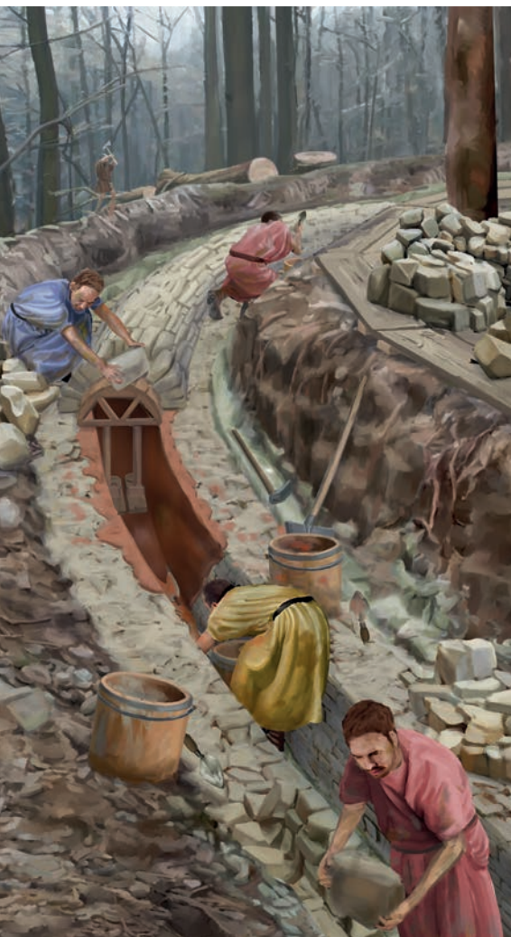
Aménagement d'un aqueduc enterré. L'image illustre de façon synthétique les différentes étapes de construction d'un tel ouvrage
