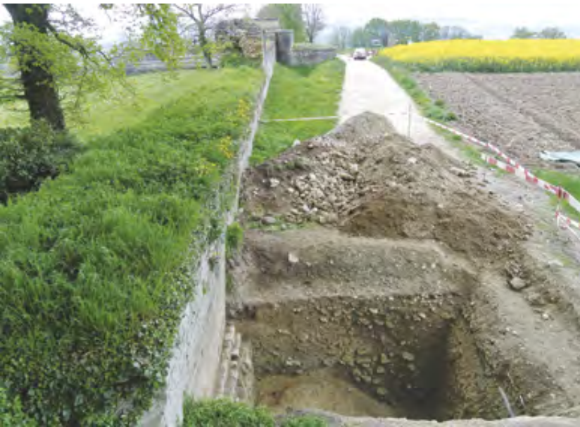
Fig. 70 2015.03. Sondage 2, fossé défensif. Situation du sondage ouvert à l’extérieur de la muraille, une cinquantaine de mètres au sud de la porte de l’Est.
