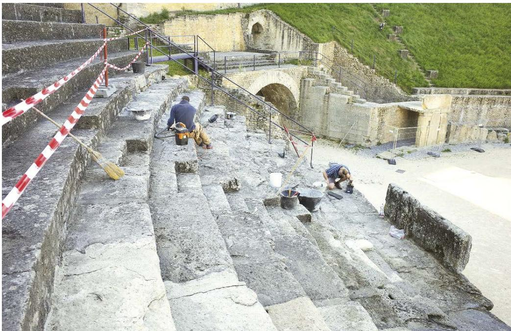
48 Travaux de jointoyage en cours sur les gradins de l'amphithéâtre.
