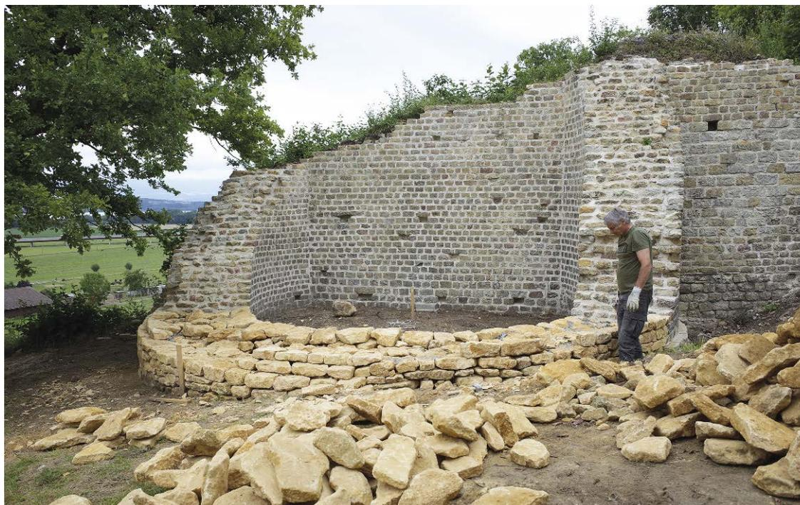
**53** Édouard Rubin sélectionne des blocs de calcaire jaune pour remonter quelques assises de marquage de la tour T3.
