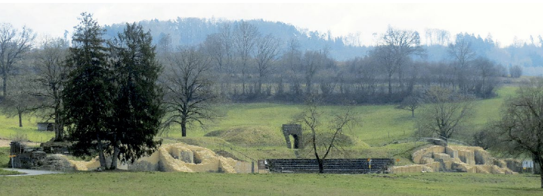
Fig. 18 – Vue des murs de soutènement des gradins (cavea), à l'issue des travaux de 2015. L'unité architecturale du théâtre est désormais à nouveau perceptible même de loin
