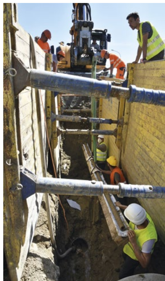
Route de contournement. Prélèvement par le laboratoire de conservation-restauration d'un segment de plus de 5 m d'une conduite en plomb parfaitement conservée à son emplacement d'origine
