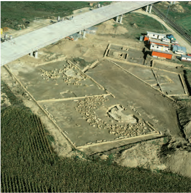
Abb. 153 – Übersicht über das Ausgrabungsgelände von En Chaplix im Sommer 1989. Im Vordergrund die Umfriedungen und die Fundamente der Grabmonumente; oben links der Viadukt der Autobahn während dem Bau.
