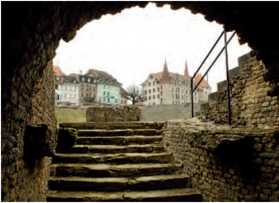
Abb. 50 – Amphitheater. Blick auf die originale Treppe des südlichen Nebengangs, der von der Place du Rafour zum Podium über dem Arenaumgang führte.
