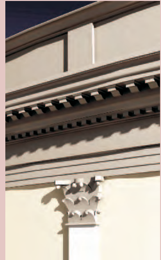
Abb. 93 – Theater. Rekonstruktionsvorschlag für den oberen Abschluss der Umfassungsmauer mit von korinthischen Pilastern getragenen Gesims und abschliessender Attika.
