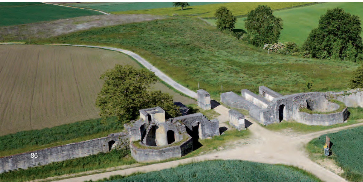
Abb. 118 – Stadtmauer. Blick von Osten auf das Osttor (links) und die Tornallaz (rechts).
