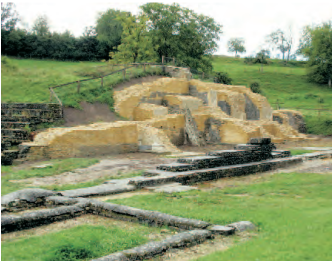
Abb. 94 – Theater. Südwestliche Eingangshalle nach den Restaurierungsarbeiten von 2012/2013.
