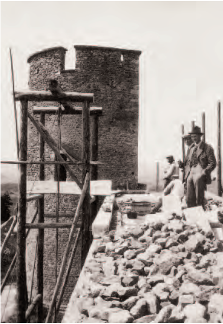
Abb. 115 – Stadtmauer. Restaurierungs- und Wiederaufbauarbeiten südlich der Tornallaz (1916-1919).
