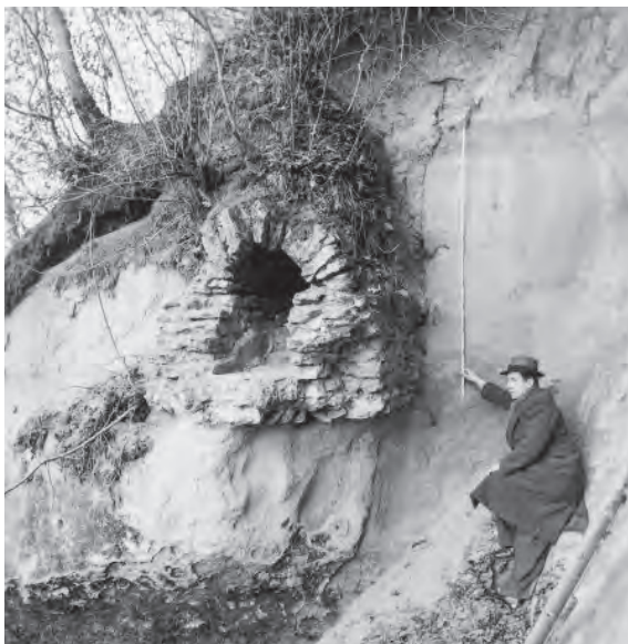
Abb. 167 – Schnitt durch die Wasserleitung von Coppet, für die eigens ein Graben aus der anstehenden Molasse ausgehoben werden musste (1941).
