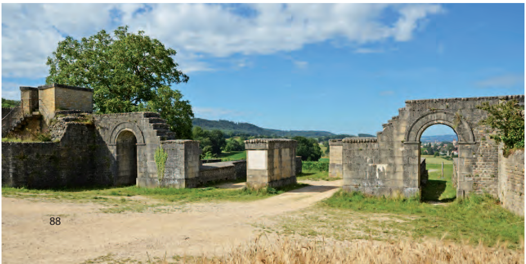
Abb. 121 – Stadtmauer. Blick auf die rekonstruierten Mauern der Ostfassade des Osttores.
