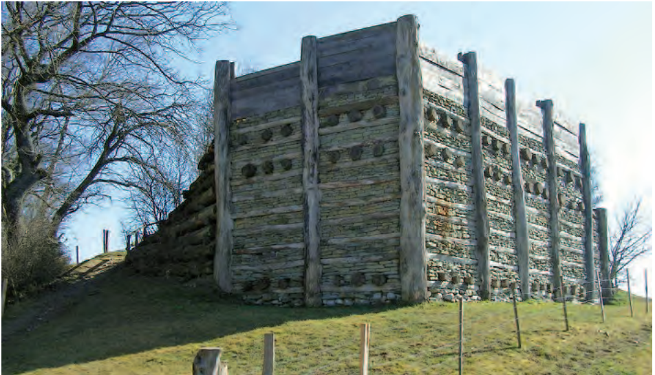
Fig. 5 – Restitution d'un tronçon du rempart de l' oppidum celtique du Mont Vully.
