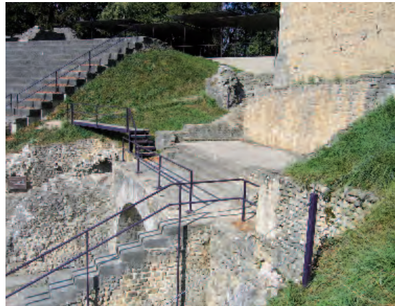
Fig. 53 – Amphithéâtre. Vue depuis le sud en direction de l'entrée principale occidentale. Sur la terrasse aménagée au-dessus, devaient peut-être être installées des représentations de divinités et de l'empereur. À droite, les puissantes fondations de la tour médiévale.
