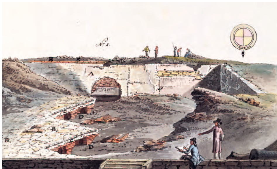
Fig. 105 – Fouille d'un établissement thermal avenchois en 1786, vraisemblablement dans l' insula 19. Aquarelle de Joseph-Emmanuel Curty.
