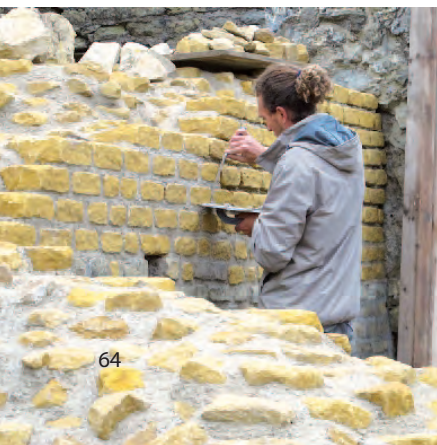
Fig. 88 – Théâtre. Travaux de restauration de 2013. Le parement d'un mur est restauré avec de nouveaux moellons de calcaire jaune.
