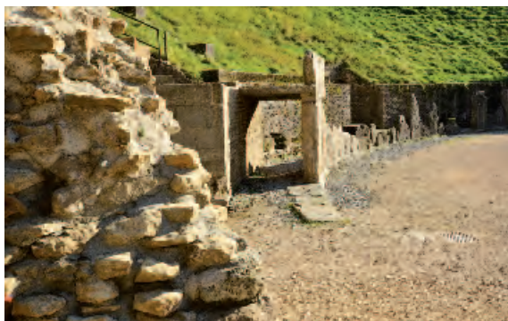
Fig. 51 – Amphithéâtre. Vue depuis l'entrée principale en direction du couloir bordant l'arène du côté sud. Au centre, un court tronçon du couloir reconstruit en 1949/50.
