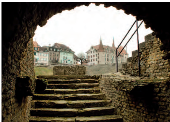
Fig. 50 – Amphithéâtre. Rampe d'escalier de la porte secondaire sud qui permettait d'accéder depuis la place du Rafour au podium aménagé au-dessus du couloir périphérique de l'arène.
