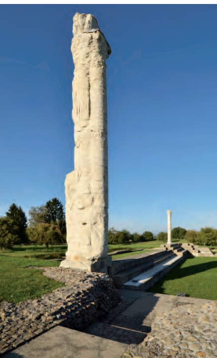
Fig. 78 – Sanctuaire du Cigognier. Restée debout depuis près de deux mille ans, la « colonne aux cigognes » faisait le lien entre le portique à colonnade orientale et l'espace frontal couvert ( pronaos ) du temple.
