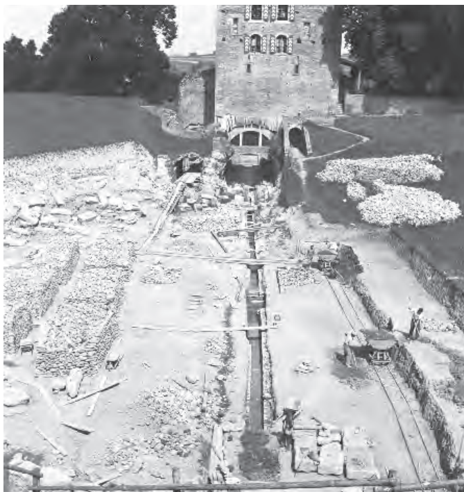
Fig. 48 – Amphithéâtre. Travaux de dégagement de l'arène en 1943.
