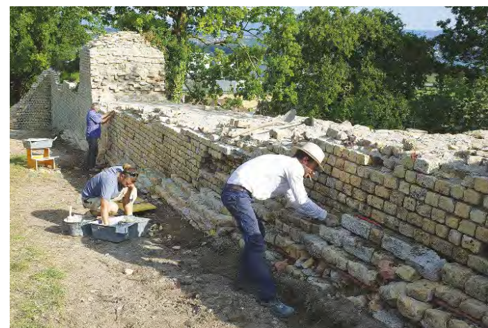
49 Travaux de conservation-restauration sur le mur d'enceinte en contrebas de la Tornallaz .
